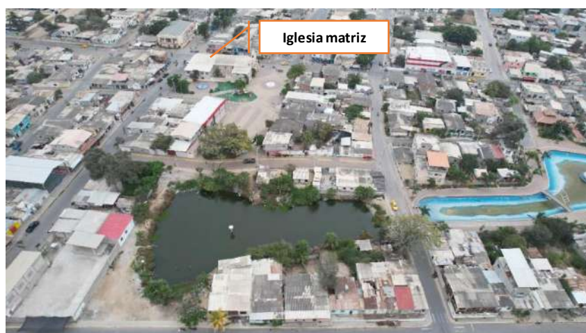
Ilustración 33 Albarrada "Centenario", ubicada en el centro de la parroquia.
