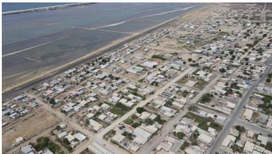
Ilustración 43 Cordón Perimetral de José Luis Tamayo
