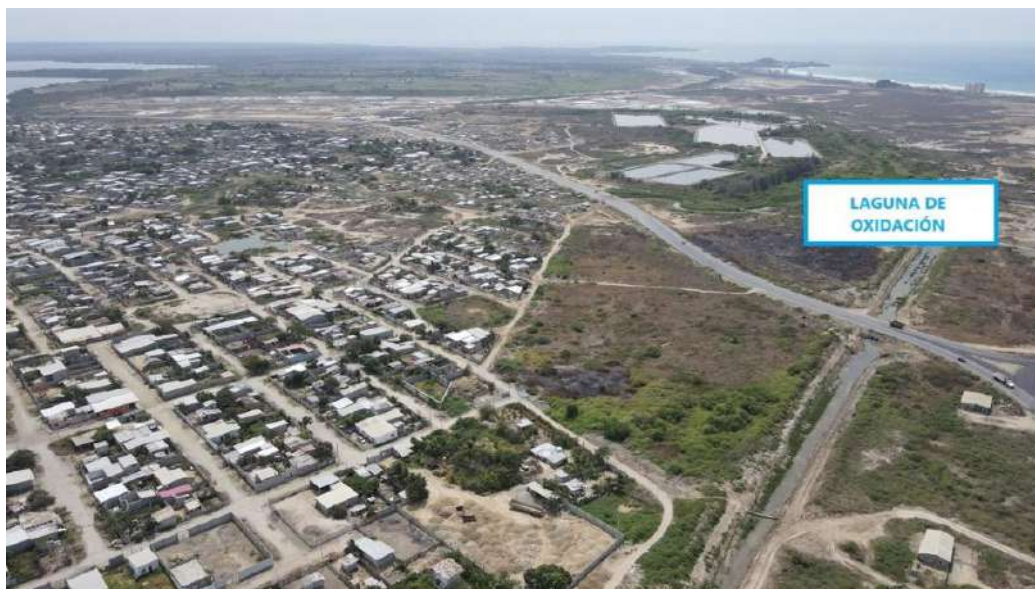
Ilustración 8.- Lagunas de Oxidación, administrada por la empresa AGUEPEN EP.
