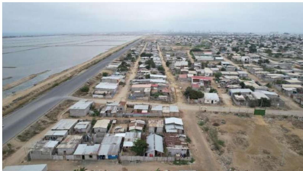
Ilustración 10.- Carretera perimetral colindante a los sectores Siria Bedoya,
