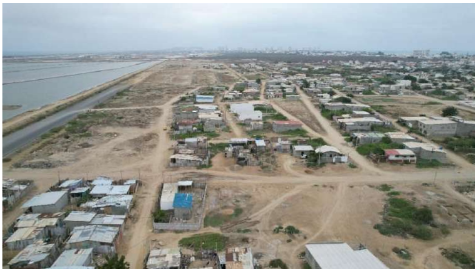
Ilustración 11.- Carretera perimetral colindante a los sectores Siria Bedoya,
