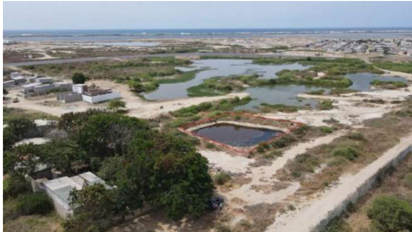
Ilustración 37 Residuos de Hidrocarburos – Contiguo a la Cdda. Punta Carnero
