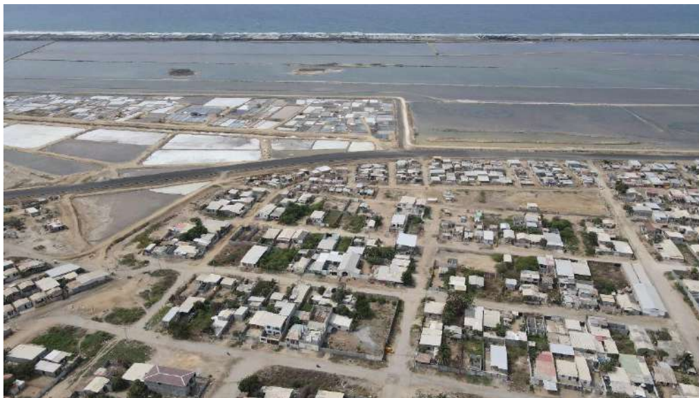
Ilustración 9.- Carretera perimetral colindante a los sectores Siria Bedoya, Vinicio Yagual y San Raymundo.
